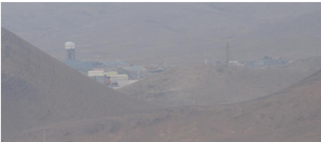
Installations de la mine d'argent exploitée par la SMI, à 3 km de Imider
